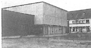
Le chantier de la salle multifonctions.
